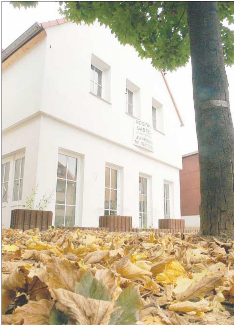
Wird wohl noch länger ungenutzt bleiben: Gassert'sches Haus. —FOTO: SEEBALD
